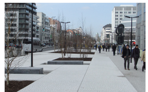
Bruksela, Plac Rogier © L. Rens / FEBELCEM
