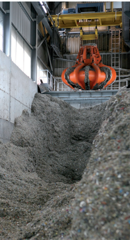
Skład paliw alternatywnych w cementowni.
