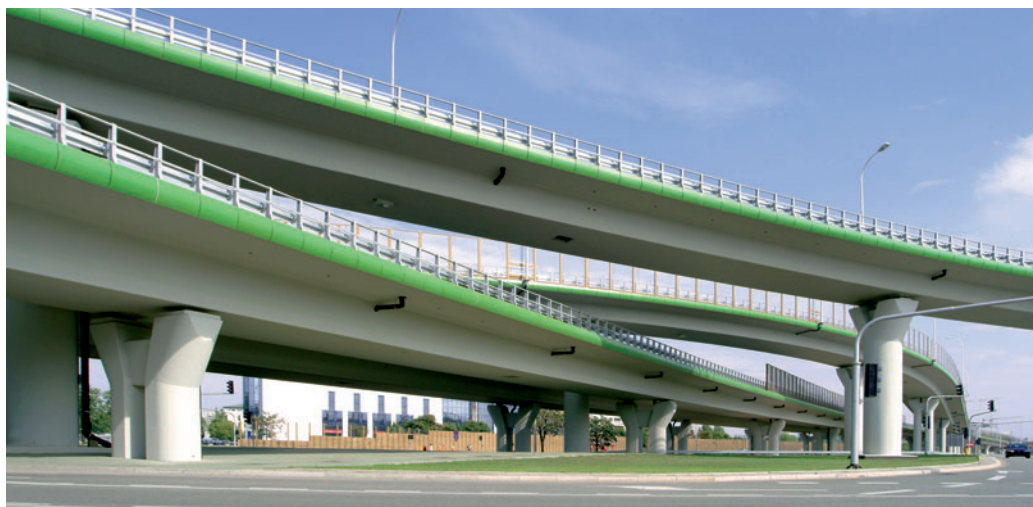
Węzeł drogowy Czerniakowski w Warszawie.
