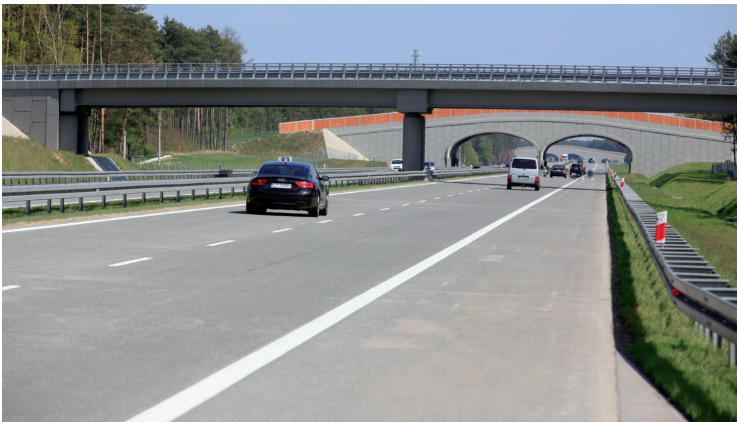
Autostrada betonowa A2.
