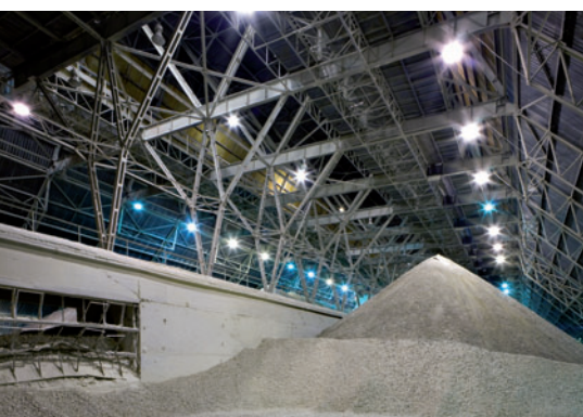
Hala surowców w cementowni.
