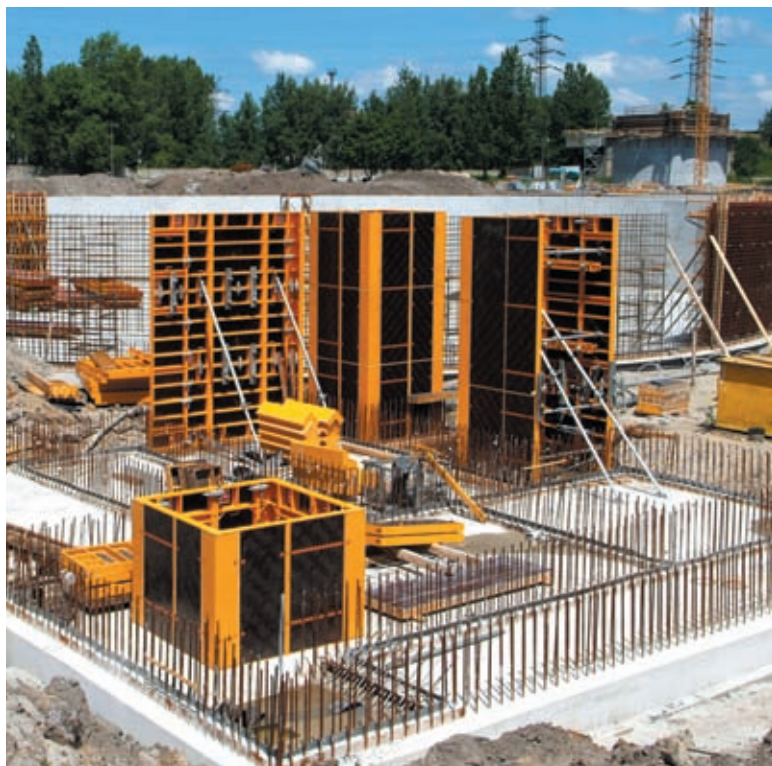
Budowa oczyszczalni ścieków w Katowicach
