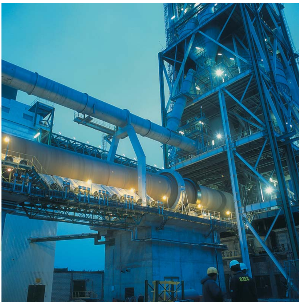
Piec do wypału klinkieru
