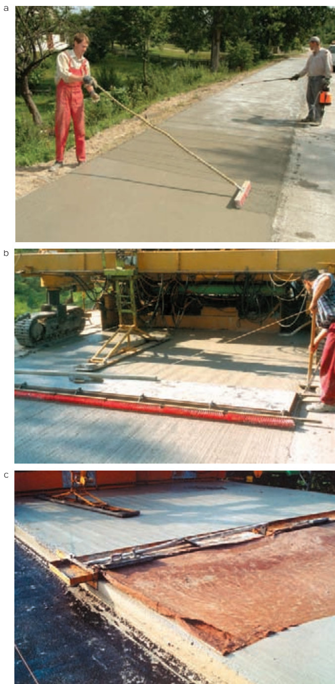
Fot. 6.4. Technologie wykańczania nawierzchni: a, b) szczotkowanie, c) zacieranie jutą
