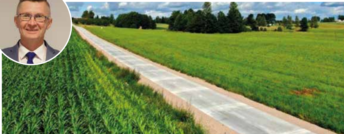
W latach 2017 – 2022 na terenie gminy Suwałki zostało zrealizowanych 16,224 km dróg o nawierzchni betonowej za łączną kwotą 7 267 154,00 zł brutto. Do budowy dróg zastosowano beton wałowany (RCC) najczęściej o grubości – 14 cm. Cena realizowanych dróg o nawierzchni betonowej była średnio o 20,59% niższa od nawierzchni asfaltowej
