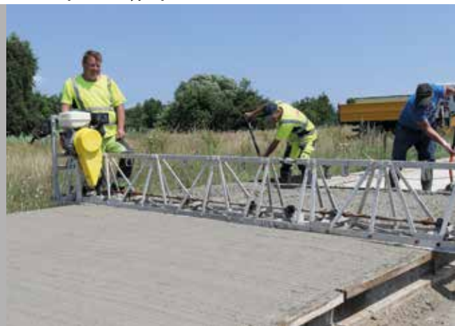
Rozkładanie nawierzchni betonowej i zagęszczanie listwą wibracyjną
