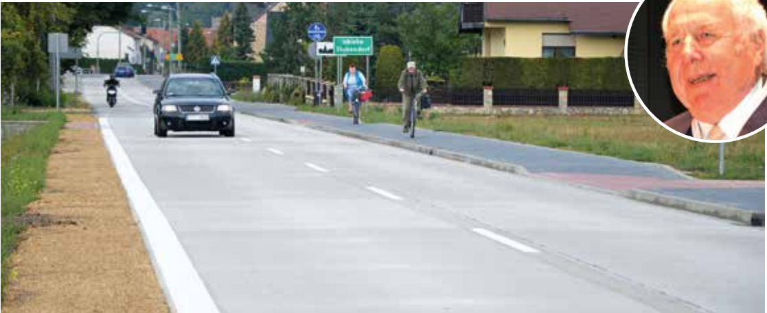
Betonowa droga Izbicko – Otmice, powiat strzelecki, woj. opolskie długość 1502 m, rok wykonania 2015
