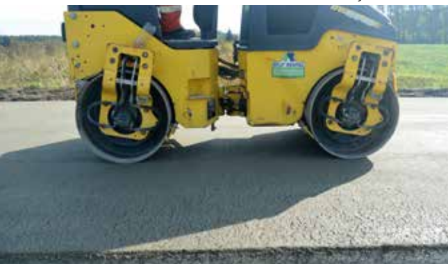
Układanie mieszanki betonowej
