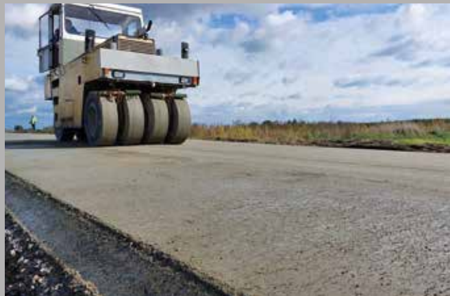
Zagęszczanie walcem na gumowych kołach
