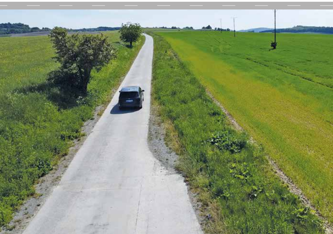
Droga z betonu wałowanego o długości 2,5 km łącząca miejscowości Owiesno i Piława Dolna (gmina Dzierżoniów, woj. dolnośląskie)
