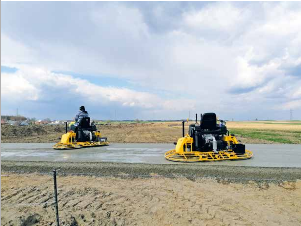
Zagęszczanie przy pomocy zacieraczek samojezdnych
