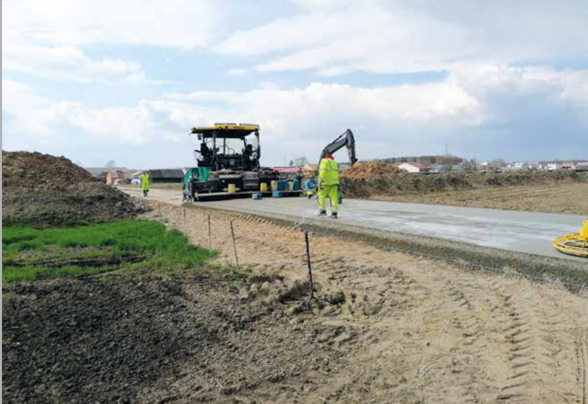
Zagęszczanie przy pomocy zacieraczek samojezdnych
