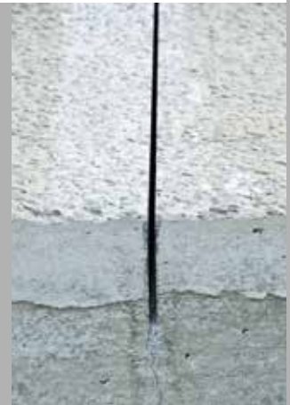
Pielęgnacja betonu za pomocą preparatów na bazie parafin, które zabezpieczają powierzchnię betonu przed szybkim odparowaniem wody. Poniżej nacinanie szczelin
