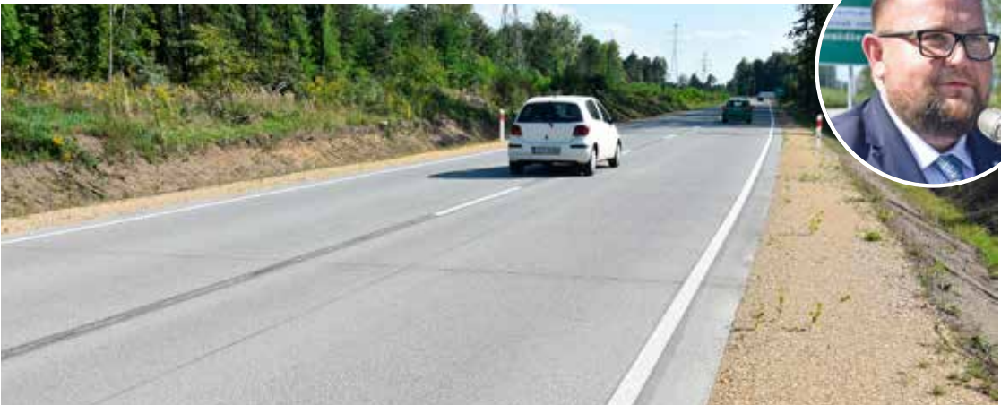
Betonowa obwodnica Malni i Choruli (woj. opolskie) 6,2 km długości, 7 m szerokości (2 x 3,5 m). Realizacja: luty 2018 r. – sierpień 2019 r.
