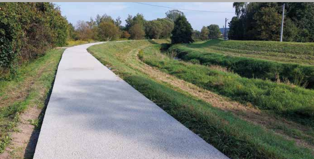
Ścieżka rowerowa z betonu wodoprzepuszczalnego wzdłuż rzeki Rudawy w Krakowie
