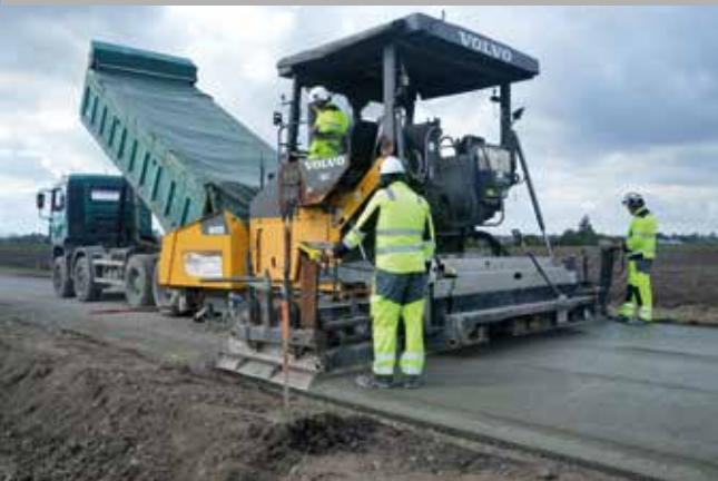
Układanie mieszanki betonowej
