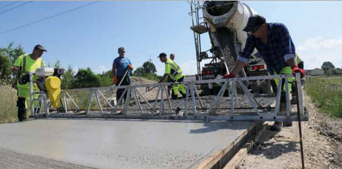
Rozkładanie nawierzchni betonowej i zagęszczanie listwą wibracyjną
