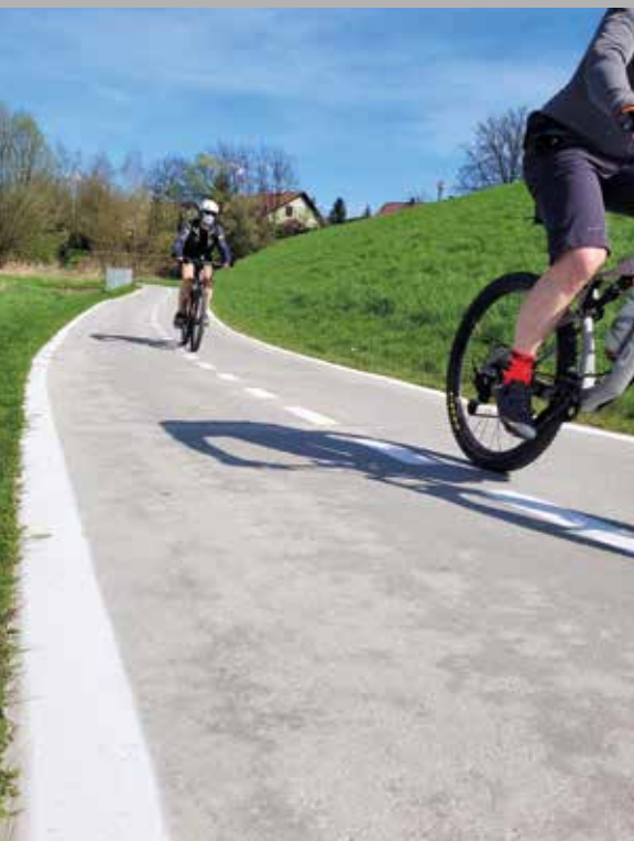
Ścieżka rowerowa z betonu wałowanego w Krakowie
