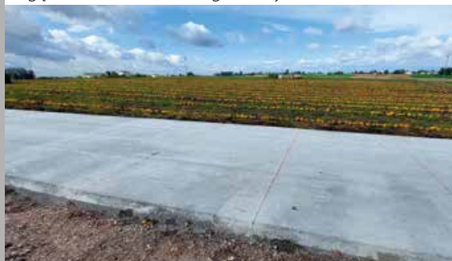
Nacinanie szczelin poprzecznych i podłużnych
