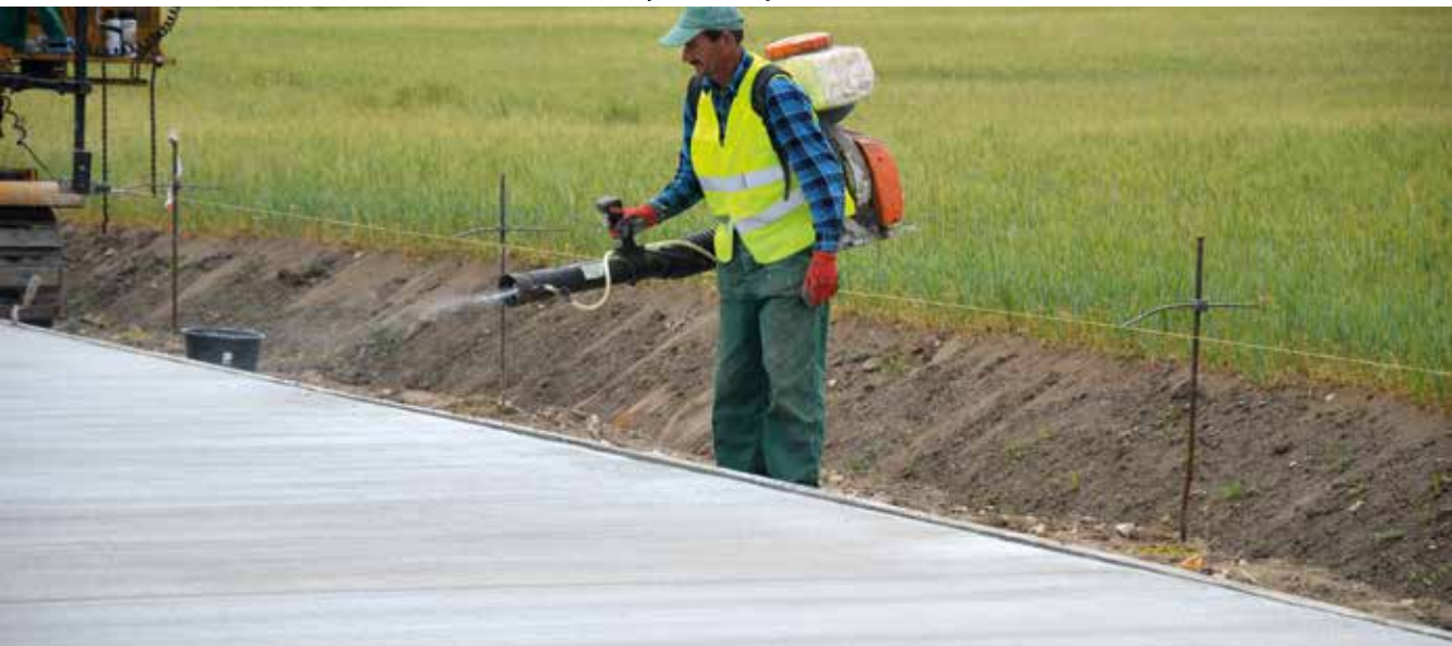
Pielęgnacja betonu za pomocą preparatów na bazie parafin, które zabezpieczają powierzchnię betonu przed szybkim odparowaniem wody. Poniżej nacinanie szczelin
