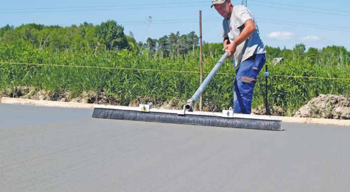
Teksturowanie nawierzchni betonowej szczotką
