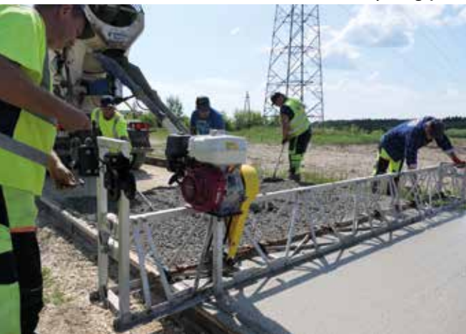
Rozkładanie nawierzchni betonowej i zagęszczanie listwą wibracyjną
