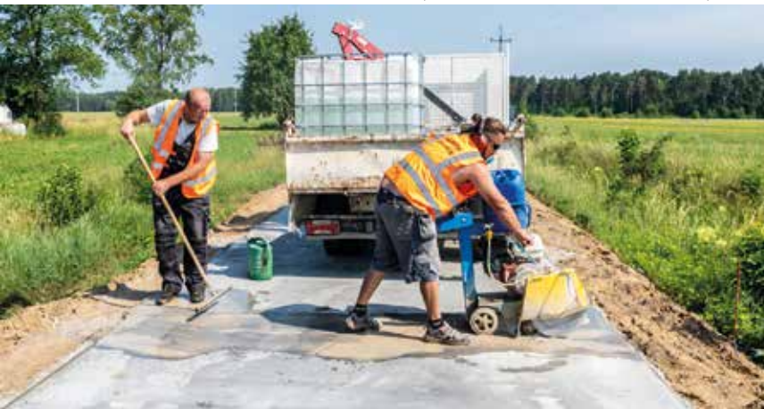
Pielęgnacja betonu za pomocą preparatów na bazie parafin, które zabezpieczają powierzchnię betonu przed szybkim odparowaniem wody. Poniżej nacinanie szczelin
