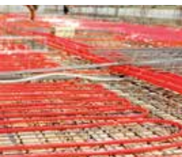
Rys. 7.3. Moduły stropów aktywowanych termicznie – system Rehau [2]
