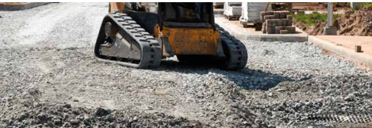
Rys. 13.2. Wykorzystanie kruszywa betonowego z recyklingu przy budowie drogi (Fot. ITB)
