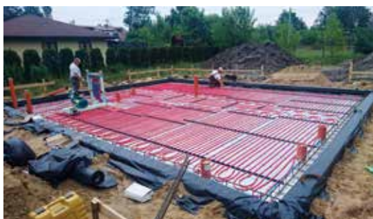
Rys. 7.4. Etapy budowy grzewczej płyty fundamentowej [3]
