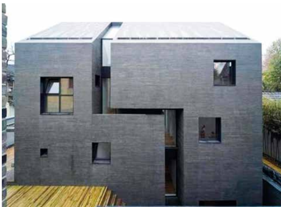
Rys. 12.1. Wykorzystanie porożbiorkowych prefabrykatów betonowych w nowym budynku (fot. Iwan Baan)
