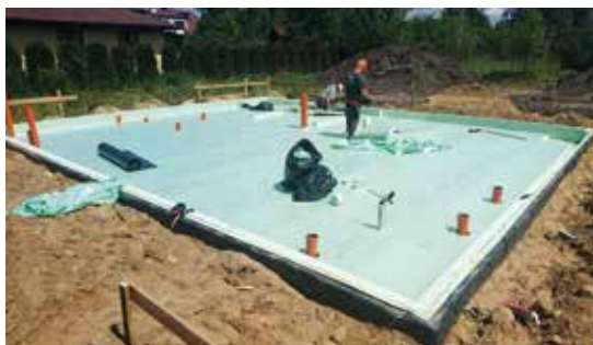
Rys. 7.3. Moduły stropów aktywowanych termicznie – system Rehau [2]
