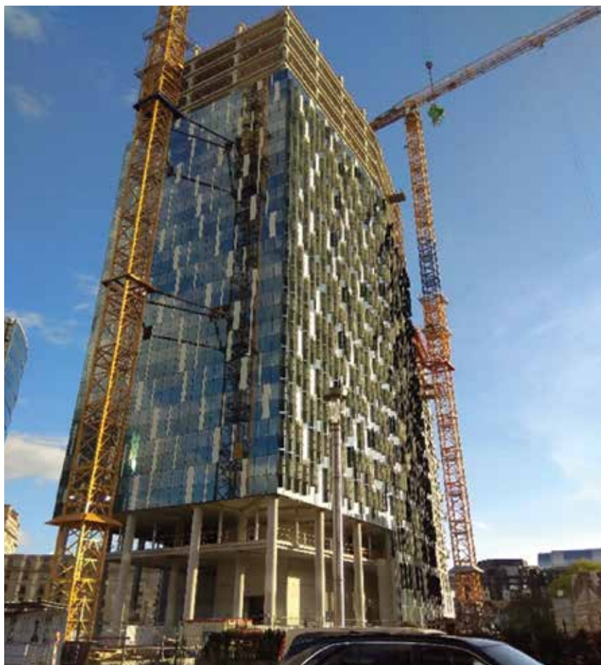
Rys. 1.1. Typowy budynek biurowy w technologii żelbetu (fot. Piasecki 2017)
