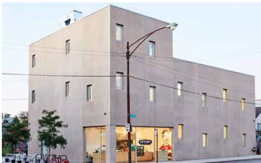
Rys. 3.3. Przykładowy budynek wybudowany w technologii prefabrykatów betonowych (fot. ITB)
