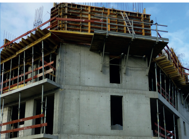
Fot. 6.1 – Monolityczne i prefabrykowane ściany żelbetowe mają nie tylko dużą nośność, ale i bardzo dobrze usztywniają bryłę budynku
