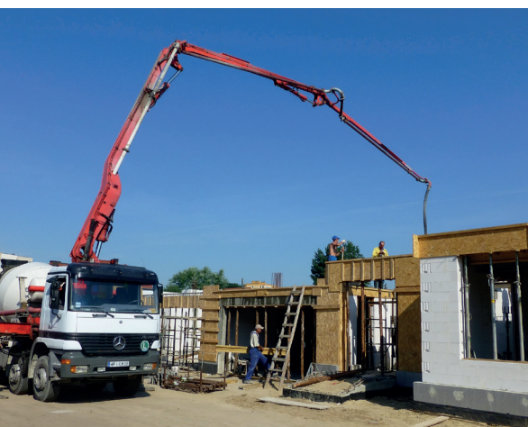
Fot. 1.3 – Przywieziona betonowozami mieszanka jest podawana pompą bezpośrednio na deskowanie
