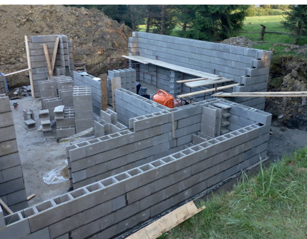
Fot. 3.3 – Zwłaszcza do wykonania ścian piwnic stosuje się betonowe pustaki zasypowe, które można zbroić pionowo i poziomo
