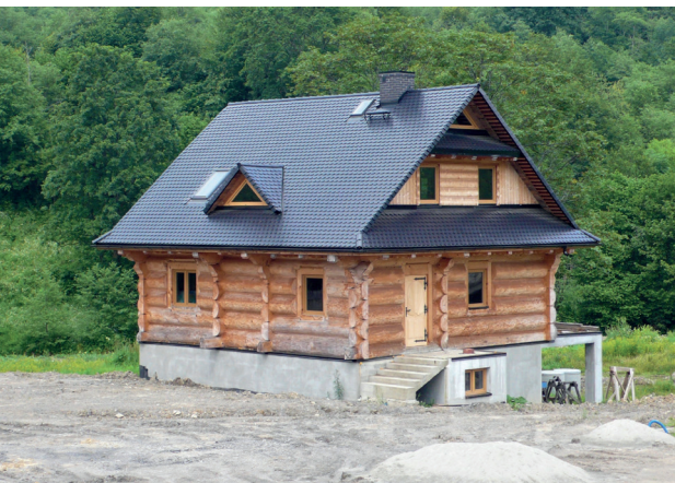
Fot. 2.1 – Ze względu materiałowych i technologicznych domy z okrągłych bali są drogie, a ich budowa trwa długo
