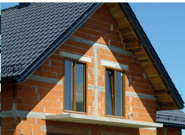
Fot. 5.4 – Konstrukcja żelbetowa, składająca się ze słupów i belek, chroni ściany szczytowe przed wyróceniem przez wiatr
