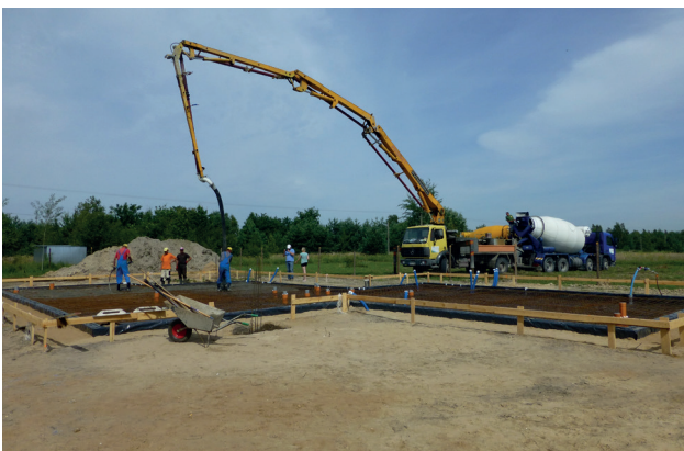
Fot. 3.5 – Na osłoniętych folią płytach polistyrenu ekstrudowanego układa się zbrojenie płyty fundamentowej, a następnie betonuje ją mieszanką z wywrotni
