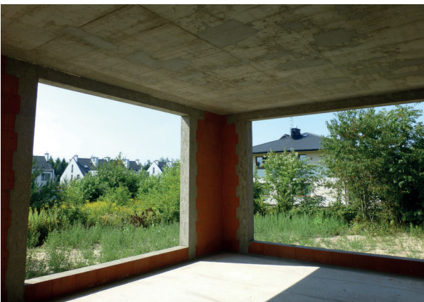
Fot. 5.1 – Składająca się ze słupów i belek konstrukcja żelbetowa umożliwia montaż wielkowymiarowych okien w ścianach domu
