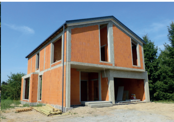
Fot. 2.4 – Żelbetowy szkielet zdecydowanie lepiej usztywnia dom niż ściany wymurowane z bloczków lub pustaków, bez wypełniania pionowych spoin
