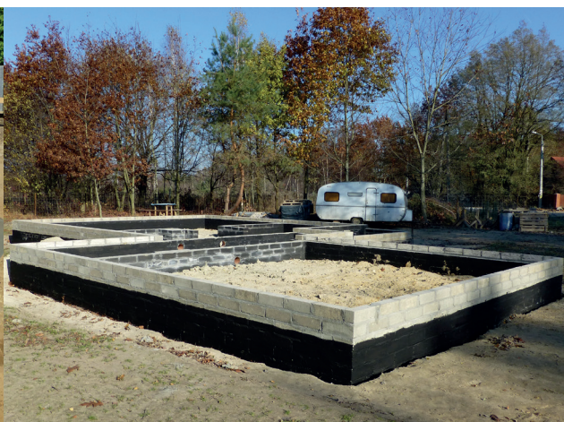
Fot. 3.2 – Do budowy ścian fundamentowych zazwyczaj używa się betonowych bloczków – pełnych lub otworowych
