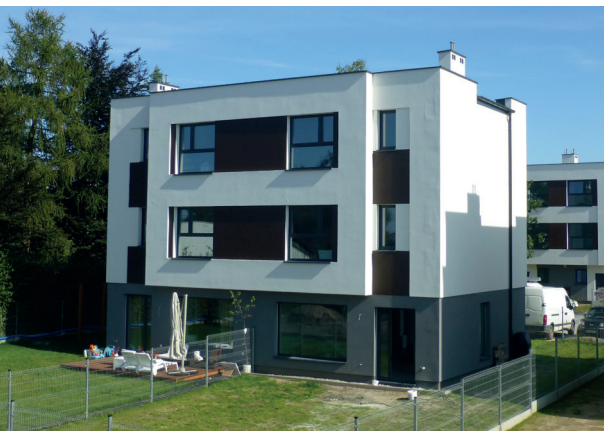
Fot. 7.1 – Także w polskim klimacie płaskie dachy mogą bardzo dobrze chronić dom przed opadami atmosferycznymi oraz niską i wysoką temperaturą
