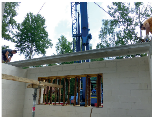
Fot. 4.3 – Stropy z prefabrykowanych płyt z betonu sprężonego montuje się szybko, bezpośrednio z samochodu, który je przywiózł na budowę
