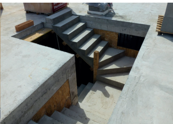
Fot. 8.3 – Dzięki przestrzennej konstrukcji połączone ze stropem schody żelbetowe stanowią dodatkowe usztywnienie bryły budynku
