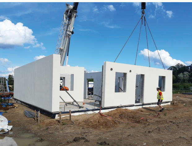
Fot. 1.1 – Coraz częstszym widokiem na budowach są prefabrykowane betonowe elementy domów
