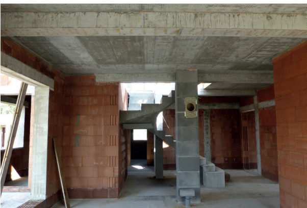
Fot. 4.1 – W domach murowanych wykonuje się przede wszystkim stropy żelbetowe – są sztywne, niepalne i „ciche” a dodatkowo usztywniają budynek
