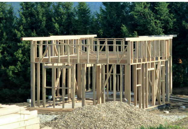
Fot. 2.3 – Drewnianą konstrukcję lekkich domów szkieletowych wykonuje się z suszonych komorowo bali, czterostronnie struganych i ze szfowanymi krawędziami
