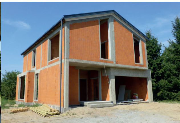
Fot. 5.2 – Są domy, w których za sztywność budynku i bezpieczne przeniesienie obciążeń na fundament odpowiada przede wszystkim szkielet żelbetowy
