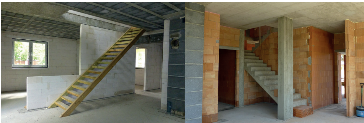
Fot. 8.1 – Jeśli w domu murowanym mają być schody drewniane, to na czas budowy trzeba w nim zamontować schody tymczasowe
