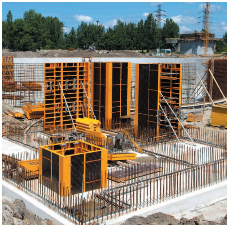
Budowa oczyszczalni ścieków w Katowicach
